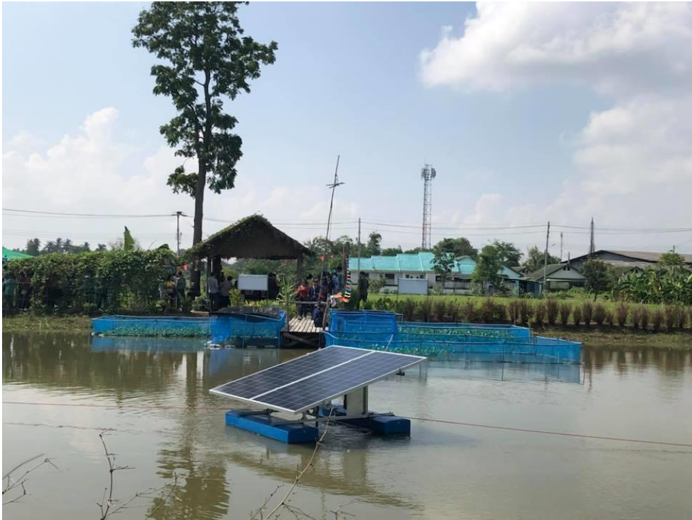
รูปที่ 13 การติดตั้งทดสอบในบ่อน้ำ
